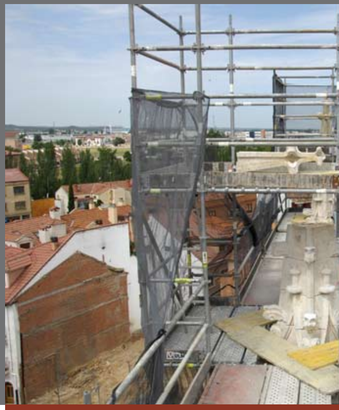
Fases constructivas de la recuperación de los
