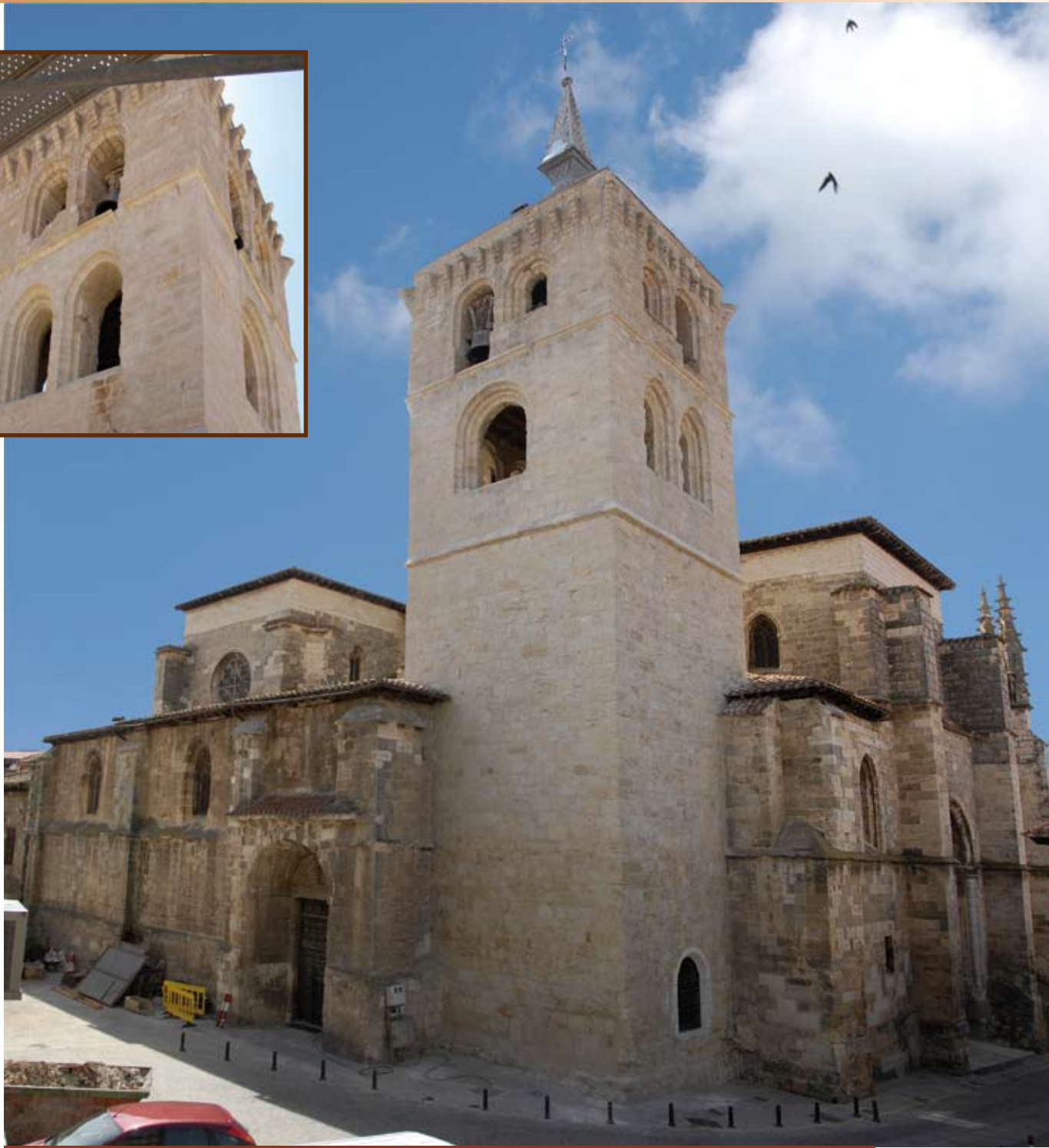
Imagen final de la torre del campanario y su resultado tras quitar el andamiaje usado para la restauración.
