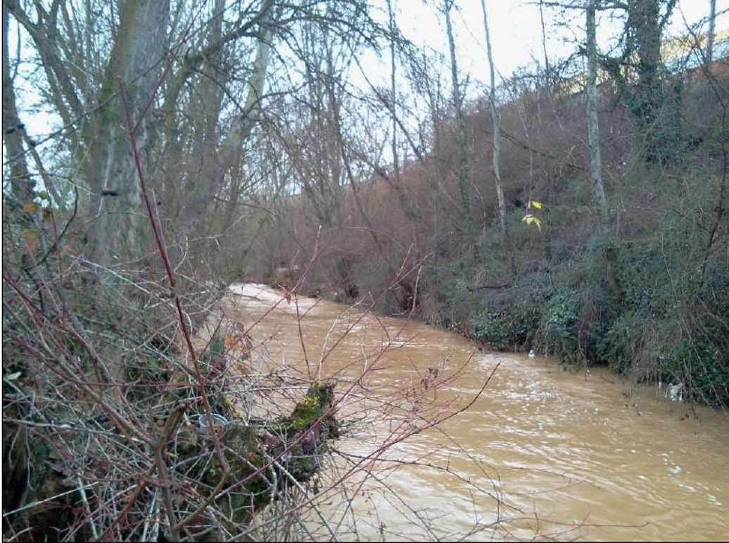
Sección tipo del río Arandilla, con abruptos taludes en su margen izquierda.
