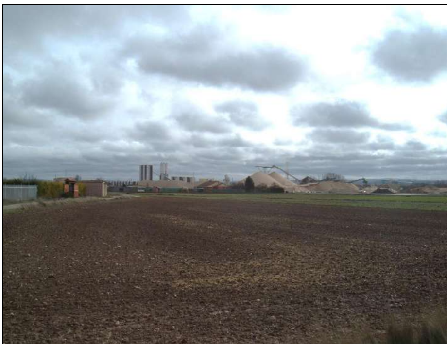
Instalaciones de ARTEPREF
