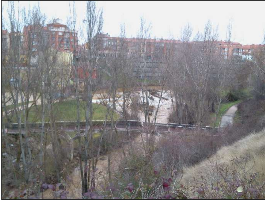
Pasarela que comunica el paseo fluvial de la margen izquierda con el Parque de La Isla.
