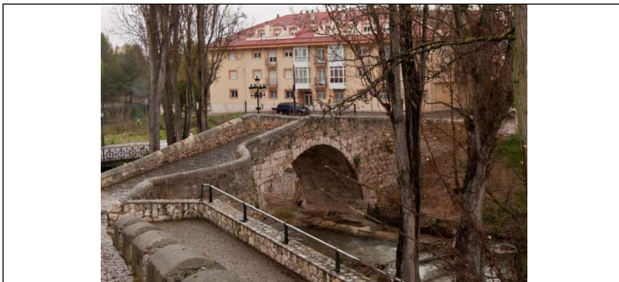
Vista general del puente de San Juan, fotografía realizada desde el este en dirección oeste.
