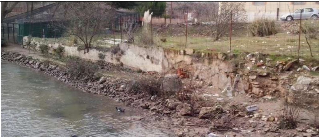
Vista general de las parcelas donde pueden quedar restos de las antiguas Tenerías.
