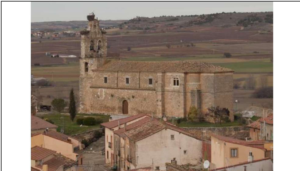
Vista de la fachada sur de la iglesia de San Cristobal y parte del entorno con protección.
