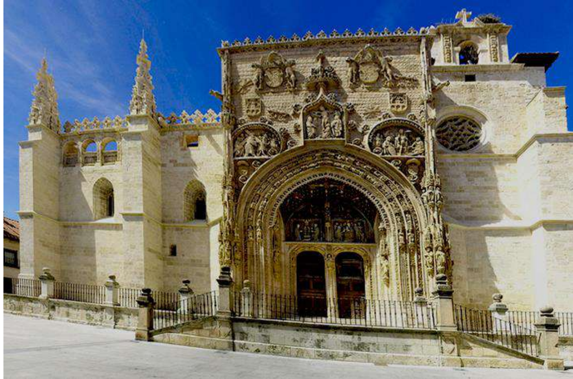
Iglesia de Santa María. Fachada sur.
