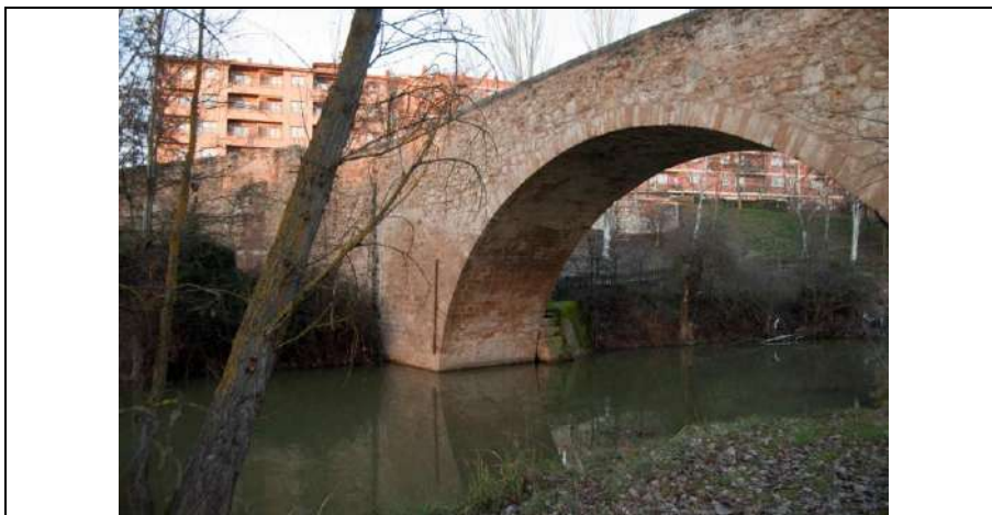
Vista del puente de Conchuela, fotografía tomada desde el suroeste en sentido norte
