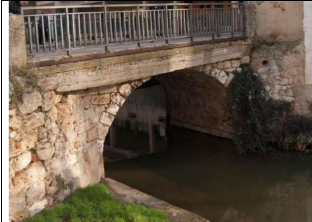
Vista general del puente , fotografía realizada desde la plaza donde se localiza la Fuente.
