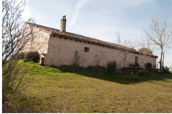
Lateral oeste y desnivel existente en el mismo
