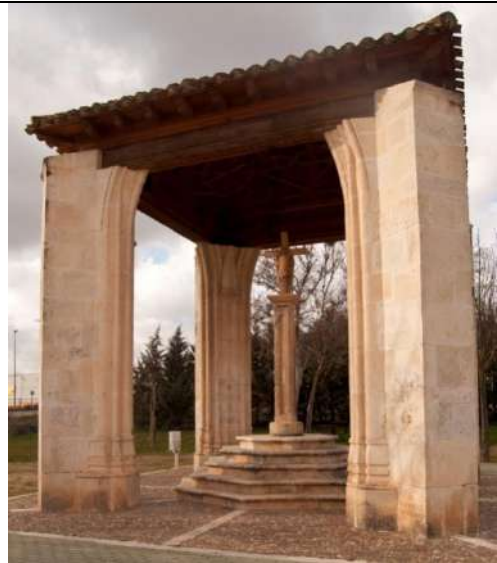
Vista del crucero y de la cubierta que lo protege. Sito en el entorno oriental de la ermita
