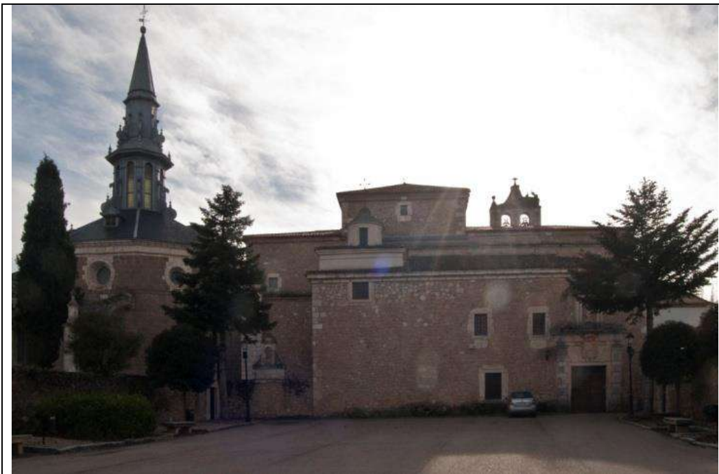
Vista general del monasterio de San Pedro Regalado. Fotografía realizada desde el norte en dirección sur.
