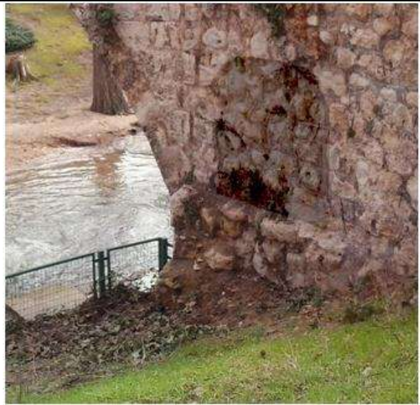
Detalle del segundo ojo del puente.
