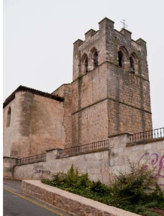
Torre de la iglesia de San Juan, obsérvese como el cuerpo de la nave del evangelio se adosa a la nave central, la cual a su vez está adosada a la torre.
