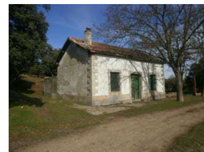
Casa del canal
