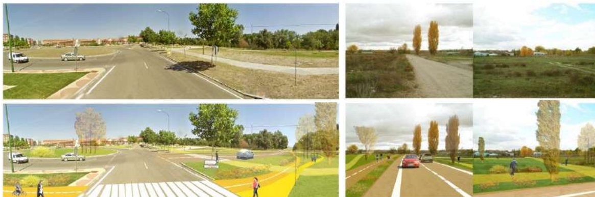
Antes y después de la conexión de la Ronda Sureste con Allenduedero
