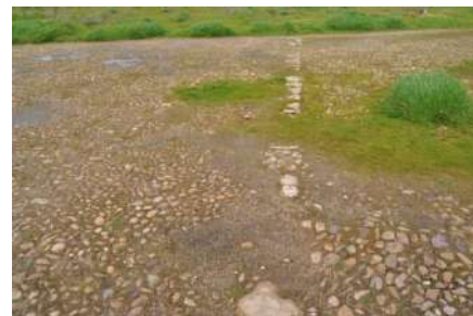
Eras de Santa Catalina, estado actual
