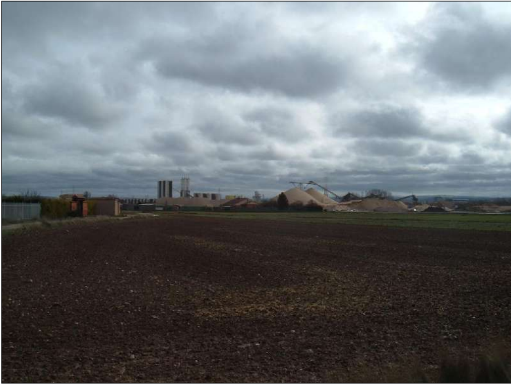
Instalaciones de ARTEPREF
