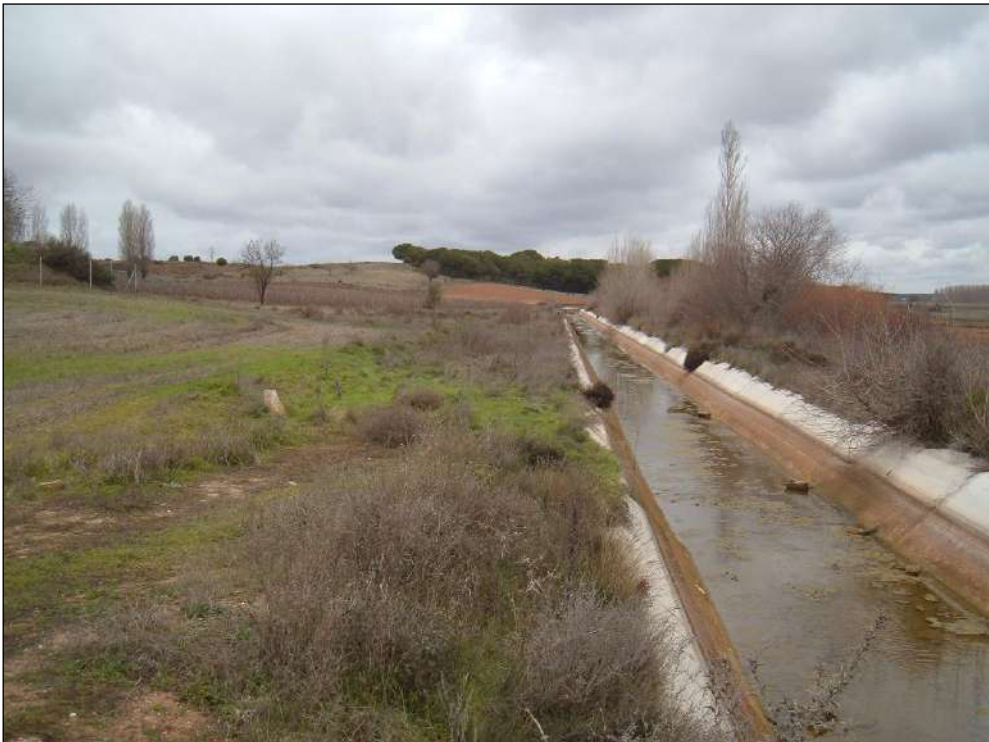
Canal de Guma al sur de Prado Marina. Al fondo, Cerro de Hoyo Verde.
