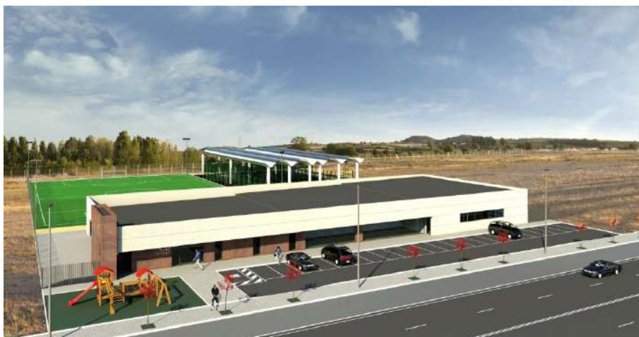
fig. 3. Centro Deportivo Pradosport en el polígono Prado Marina
