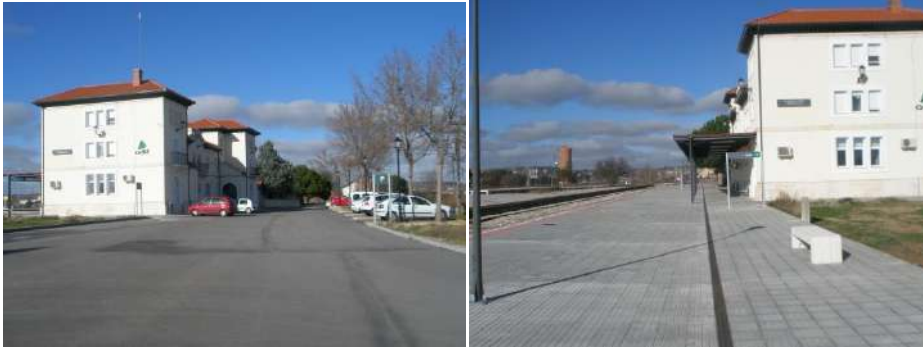
Estación de El Montecillo
